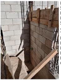
LA UBICACIÓN DEL MOTOR SERA EN LA PARTE POSTERIOR DEL FOSO DE INSTALACION. SE SOLICITA SALIDA A 220 VOLTS PARA ALIMENTACION DE MOTOR Y UNA LINEA ALTERNA PROVISIONAL PARA PODER REALIZAR TRABAJOS DE INSTALACION., YA HAY 2 PASOS CON TUBERIA DE 2 PULGADAS PARA PASO DE CABLES Y TUBING.
