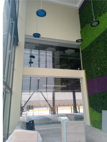
TIENE UNA ALTURA DE LEVANTE DE 8.225 MTS Y EN LA VISITA SE ACLARA QUE SE FIJARA SOBRE LO QUE ACTUALMENTE ES UN MURO VERDE, SE HACE MENCION DE ESTO PARA QUE EL INSTALADOR CONSIDERE REFUERZOS EXTRAS DE FIJACION DE VIGAS DE ACERO DETRÁS DEL MURO DE TABLAROCA.
