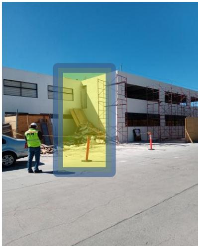
EL ELEVADOR TENDRA UNA SEPARACION DE LA PARED DE 8 PULGADAS, DEBIDO A QUE SE COLOCARAN BAJADAS PLUVIALES DETRÁS DEL ELEVADOR.
