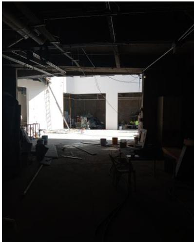
EL CAMION DE DESCARGA NO PODRA REBASAR LOS 5 METROS DESDE EL ACCESO, YA QUE HAY UNA CISTERNA Y TAMBIEN DEBERAN LIMITAR LA PROFUNDIDAD DE LOS BOQUETES DE FIJACION DE LAS RAMPAS, YA QUE LA LOSA ES DE 20 CMS DE ESPESOR.
