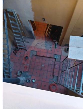
TIENE UNA ALTURA DE LEVANTE DE 4.80 MTS Y EN LA VISITA SE INDICA QUE EL FOSO ES DE 20 CMS DE PROFUNDO LIBRE. SE ADAPTARA UN CUBO DE ESTRUCTURA METALICA PARA DAR CONTINUIDAD AL PISO DE LA PLANTA ALTA.
