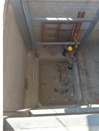
TIENE UNA ALTURA DE LEVANTE DE 4.55 MTS Y EN LA VISITA MUESTRA UNA PROFUNDIDAD DE 70 CMS, SE HACE MENCION DE ESTO, POR QUE EL RESIDENTE COLOCARA UN FIRME DE 10 CM DE PARA QUE EL FOSO TENGA PROFUNDIDAD DE 60 CMS, COMO LO ESTABLECE LA GUIA MECANICA.
