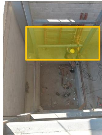
LA UBICACIÓN DEL MOTOR SERA EN LA PARTE LATERAL DEL FOSO DE INSTALACION. SE SOLICITA SALIDA A 220 VOLTS TRIFASICA POR NEUTRO Y TIERRA PARA LIMENTACION DE MOTOR Y UNA LINEA ALTERNA PROVISIONAL PARA PODER REALIZAR TRABAJOS DE INSTALACION.
