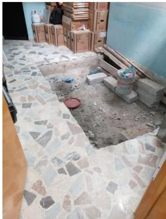
EL CLIENTE HARA MODIFICACIONES A SU PLANTA BAJA PARA LA CORRECTA COLOCACION Y BUEN FUNCIONAMIENTO DE ELEVADOR, EL MOTOR SE COLOCARA EN LA PARTE TRASERA DEL ELEVADOR.
