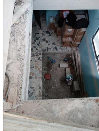
TIENE UNA ALTURA DE LEVANTE DE 2.99 MTS Y EN LA VISITA SE INDICA QUE EL FOSO ES DE 20 CMS DE PROFUNDO LIBRE, FALTA EL AFINE DE LOS LATERALES, EL FOSO TIENE MEDIDAS DE 1.78 X 2.39 METROS LIBRES.
