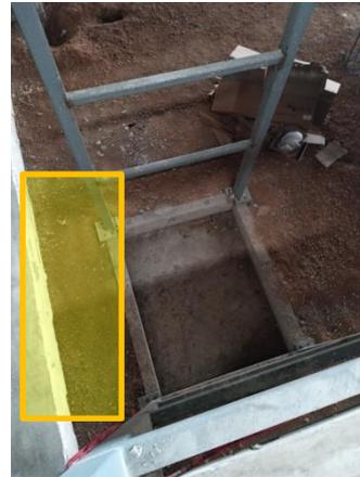
LA UBICACIÓN DEL MOTOR SERA EN LA PARTE LATERAL DEL FOSO DE INSTALACION. SE SOLICITA SALIDA A 220 VOLTS TRIFASICA POR NEUTRO Y TIERRA PARA ALIMENTACION DE MOTOR Y UNA LINEA ALTERNA PROVISIONAL PARA PODER REALIZAR TRABAJOS DE INSTALACION.
