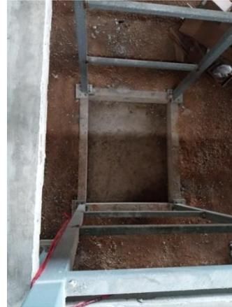
TIENE UNA ALTURA DE LEVANTE DE 4.55 MTS Y EN LA VISITA MUESTRA UNA PROFUNDIDAD DE 60 CMS , COMO LO ESTABLECE LA GUIA MECANICA.
