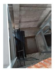
TIENE UNA ALTURA DE LEVANTE DE 4.60 MTS Y EN LA VISITA MUESTRA UNA PROFUNDIDAD DE 70 CMS, POR LO QUE SE SOLICITA LEVANTAR EL FONDO HASTA DEJAR LOS 60 CMS QUE PIDE LA GUIA MECANICA.
