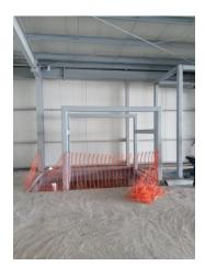
EL PUENTE TIENE UNA ALTURA DE 2.17 METROS POR LO QUE SE SOLICITA MODIFICAR LA ALTURA A 2.295 METROS COMO LO INDICA LA GUIA MECANICA.
