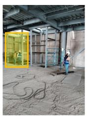
LA UBICACIÓN DEL MOTOR SERA EN LA PARTE LATERAL DEL FOSO DE INSTALACION. SE SOLICITA SALIDA A 220 VOLTS TRIFASICA CON NEUTRO Y TIERRA PARA ALIMENTACION DE MOTOR Y UNA LINEA ALTERNA PROVISIONAL 220 BIFASICA PARA PODER REALIZAR TRABAJOS DE INSTALACION.
