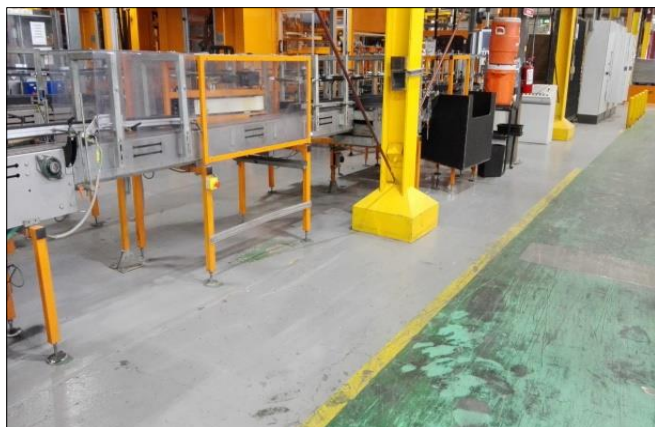
AREA DE FOSO DE ELEVADOR
