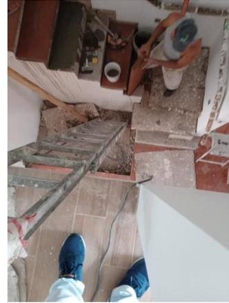
TIENE UNA ALTURA DE LEVANTE DE 2.90 MTS Y EN LA VISITA SE INDICA QUE EL FOSO DEBERA SER DE 20 CMS DE PROFUNDO LIBRE. DURANTE LA INSTALACION DEBERA DE CONSIDERARSE UN REFUERZO A 1.80 PARA FIJACION DE REFUERZO DE PUENTE.
