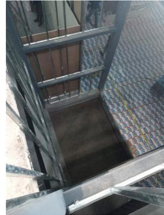
TIENE UNA ALTURA DE LEVANTE DE 4.57 MTS Y EN LA VISITA MUESTRA UNA PROFUNDIDAD DE 70 CMS, POR LO QUE SE SOLICITA LEVANTAR EL FONDO HASTA DEJAR LOS 60 CMS QUE PIDE LA GUIA MECANICA.
