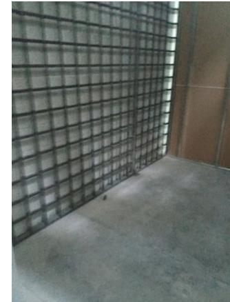
LA UBICACIÓN DEL MOTOR SERA EN LA PARTE TRASERA DEL FOSO DE INSTALACION. SE SOLICITA SALIDA A 220 VOLTS TRIFASICA CON NEUTRO Y TIERRA PARA ALIMENTACION DE MOTOR Y UNA LINEA ALTERNA PROVISIONAL 220 BIFASICA PARA PODER REALIZAR TRABAJOS DE INSTALACION.
