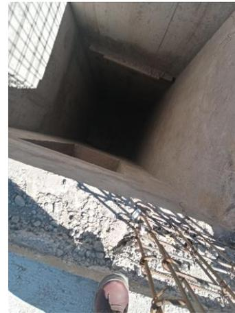
EL EQUIPO SE INSTALARA EN UN AREA DE UN HOTEL Y TIENE UN LEVANTE DE 7.33 METROS.
