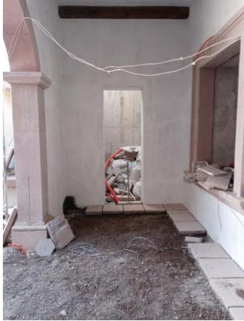
SE FABRICARA UN VANO DE 2.30 METROS DE ALTO Y UN ANCHO DE LO QUE TIENE EL FOSO ACTUAL CON TODAS LAS PREPARACIONES PARA SUS PUERTAS AUTOMATICAS.
