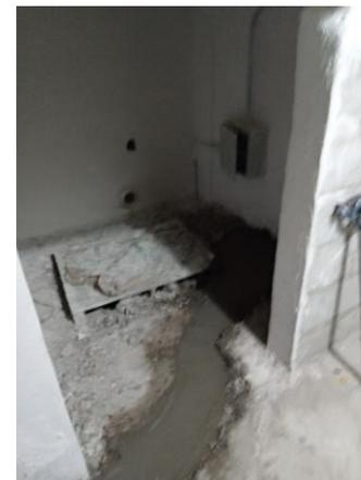
LA UBICACIÓN DEL MOTOR SERA EN LA PARTE LATERAL DEL FOSO DE INSTALACION A 5 METROS DE DISTANCIA APROXIMADAMENTE, SE USARA MANGUERA EN VEZ DE TUBING, SE SOLICITA SALIDA A 220 VOLTS TRIFASICA CON NEUTRO Y TIERRA PARA ALIMENTACION DE MOTOR Y UNA LINEA ALTERNA PROVISIONAL 220 BIFASICA PARA PODER REALIZAR TRABAJOS DE INSTALACION.
