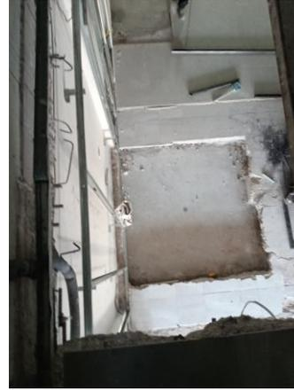
TIENE UNA ALTURA DE LEVANTE DE 4.60 MTS Y EN LA VISITA MUESTRA UNA PROFUNDIDAD DE 70 CMS, POR LO QUE SE SOLICITA LEVANTAR EL FONDO HASTA DEJAR LOS 60 CMS QUE PIDE LA GUIA MECANICA.
