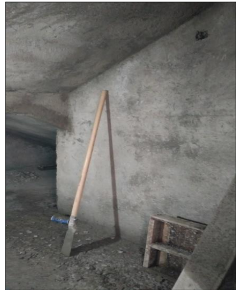
ESPACIO LATERAL DEBAJO DE ESCALERA A UN LADO DE CUBO PARA PCL CON UNA ALTURA DE 1.60 MT EN LA PARTE BAJA.
