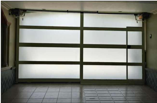
PUERTA PRINCIPAL DE ACCESO DE 2.50X2.15 DE ALTURA APROXIMADAMENTE.
