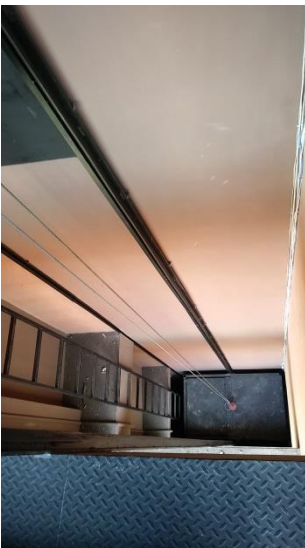
Vista tercer estación
