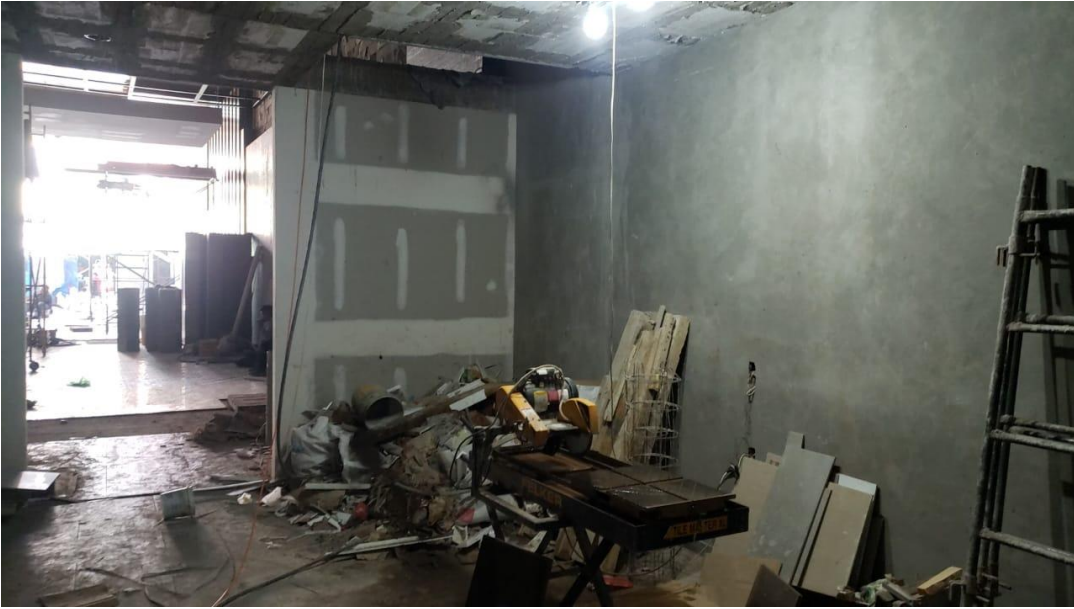
1era estación unidad hidráulica y foso
