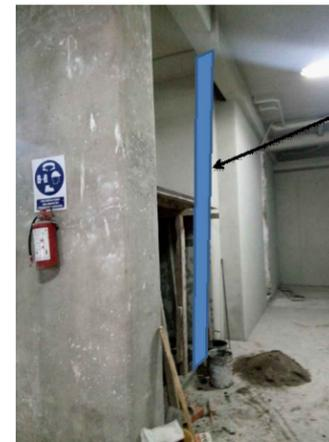
Perfil IPR de 12"x4" propiedad del cliente fijada de piso a losa
