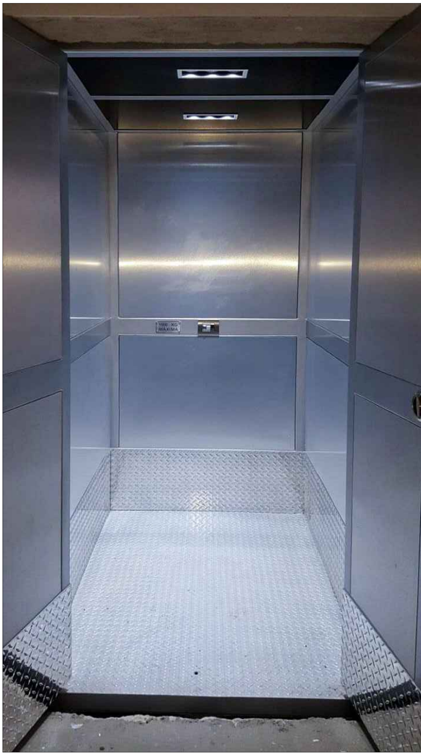
ALUCOBOND CON 3 MUROS CON FALDÓN DE LÁMINA ANTIDERRAPANTE DE 30CM
