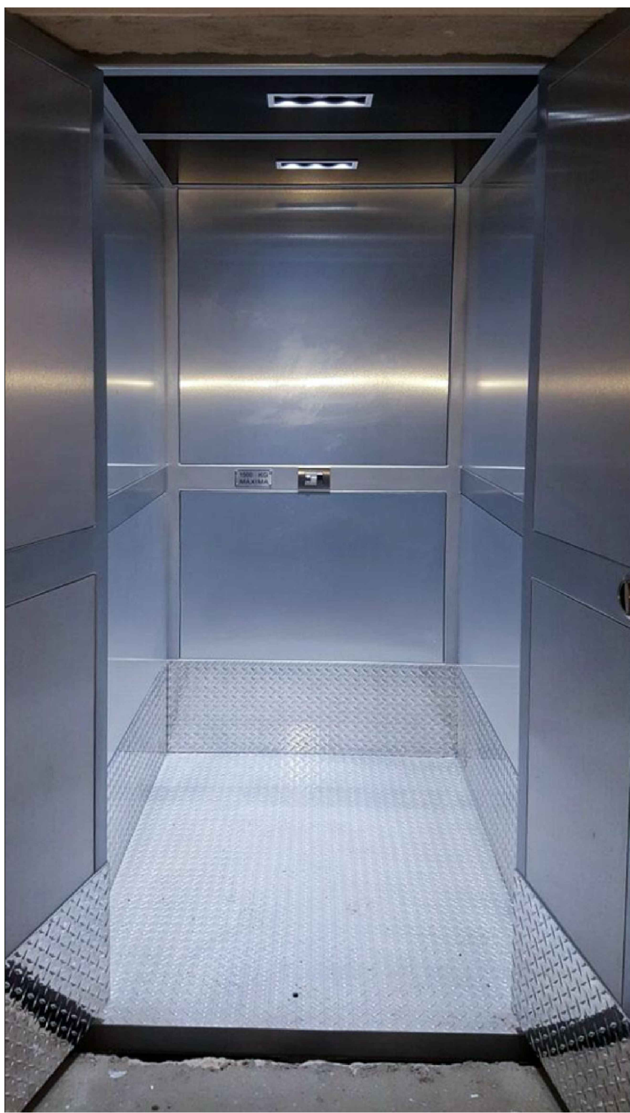
ALUCOBOND (GRIS APARENTE ACERO INOXIDABLE) CON SUS 4 LADOS CON FALDÓN DE LÁMINA ANTIDERRAPANTE DE 30CM
