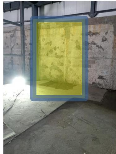
LA UBICACIÓN DEL MOTOR SERA DEL LADO DERECHO PEGADO A LA PARED, EN LA PLANTA BAJA. SE SOLICITA SALIDA A 220 VOLTS PARA ALIMENTACION DE MOTOR Y UNA LINEA ALTERNA PROVISIONAL PARA PODER REALIZAR TRABAJOS DE INSTALACION.
