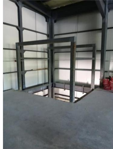
TIENE UNA ALTURA DE LEVANTE DE 4.59 Y EN LA VISITA MUESTRA UNA ALTURA DE 2.22 DE PISO DE PLANTA ALTA A LECHO INFERIOR DE CERRAMIENTO DE PTR, SE PIDE AJUSTAR A 2.30 PARA PUERTAS DE LINEA DE ELEKTRA
